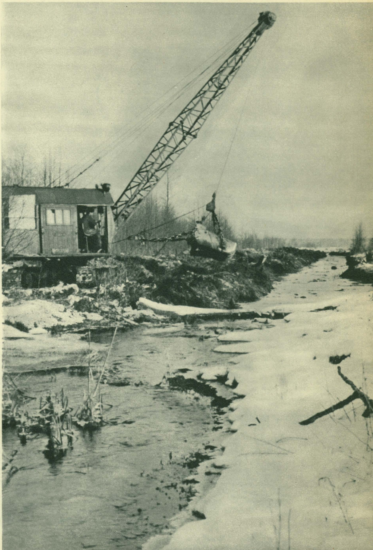
Работы по преобразованию громадных территорий ведутся в Белоруссии круглый год. И в зимние месяцы экскаваторы продолжают прокладку мелиоративной сети. На снимке — экскаватор вынимает грунт на одном из участков Куритичского канала в Полесье.
